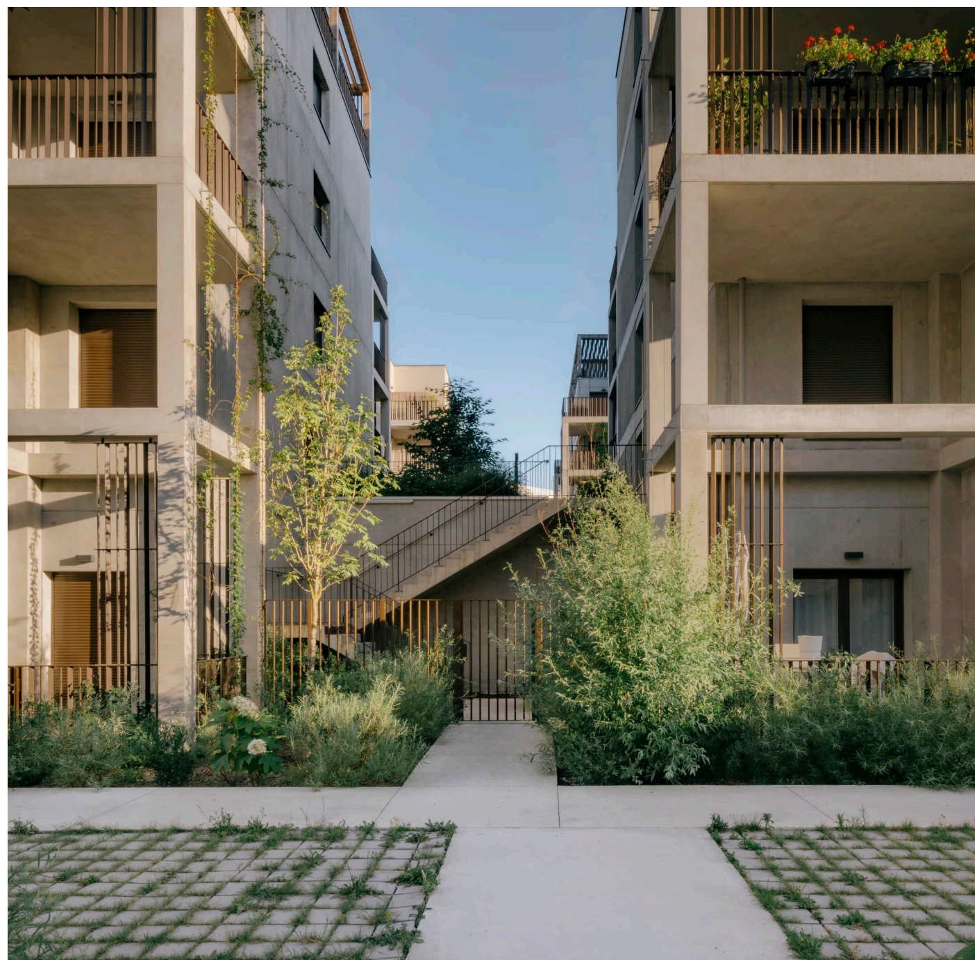
Accès à son logement en RDC
