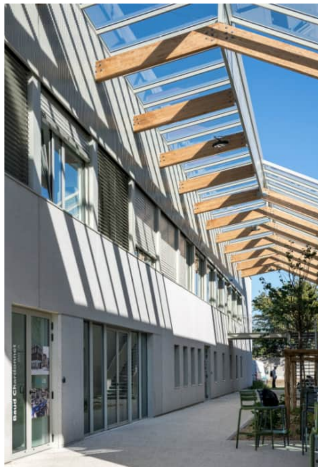
Venelle jardin séparant bâtiment exploitation et atelier
