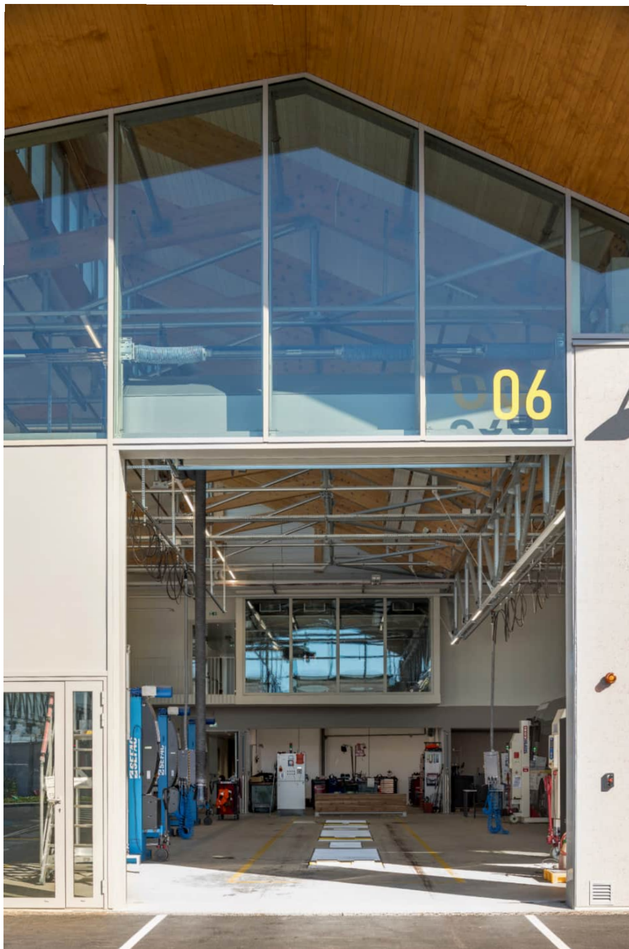
Voie de maintenance dans l'atelier
