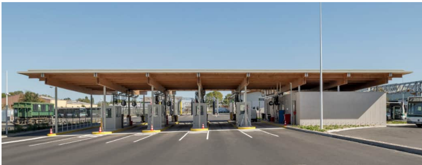
Entrée dans la station service
