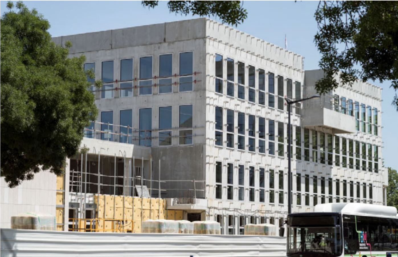
Siège en construction boulevard Georges Pompidou
