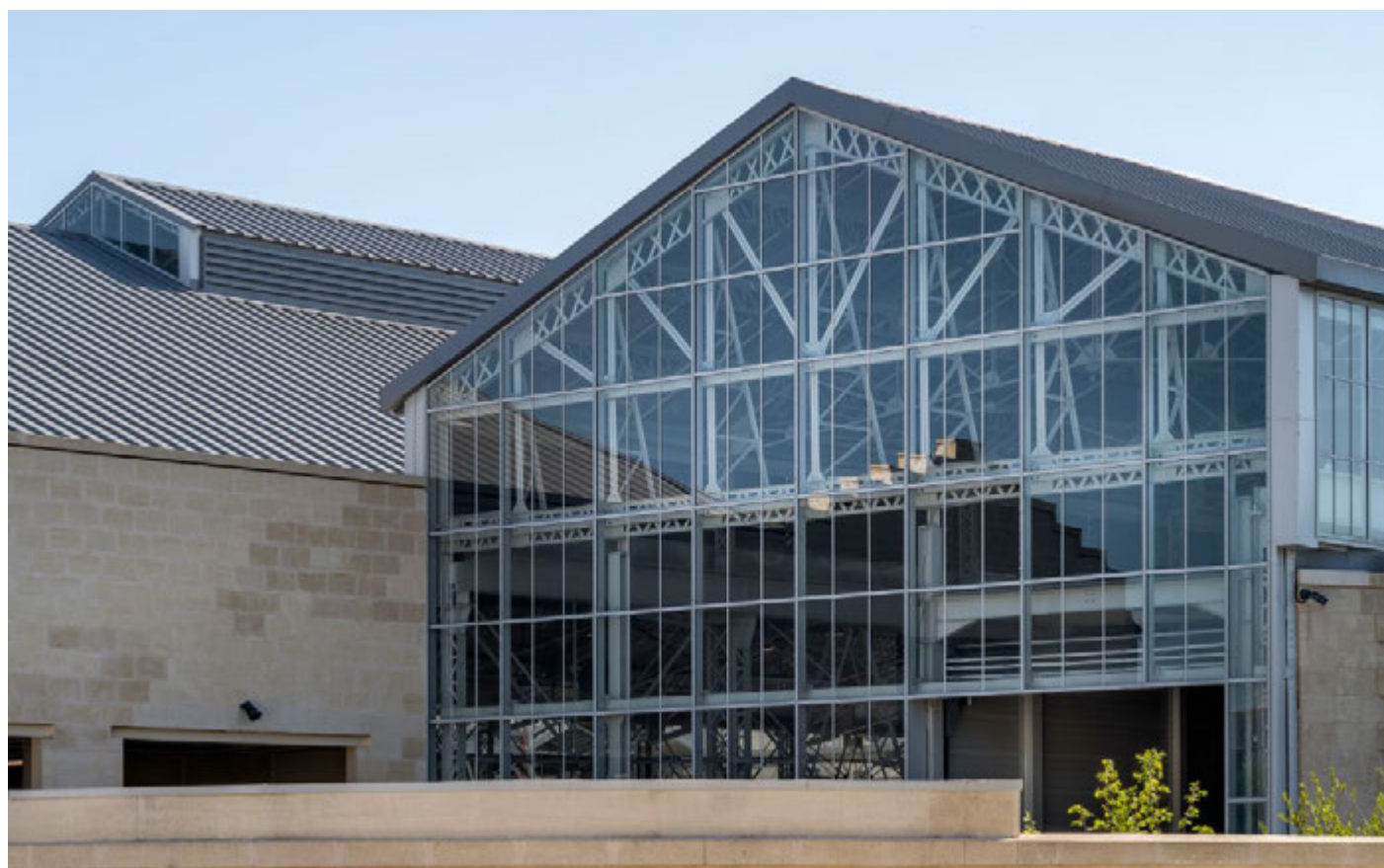
Pignon latéral vitré, entrée des bus sur le site
