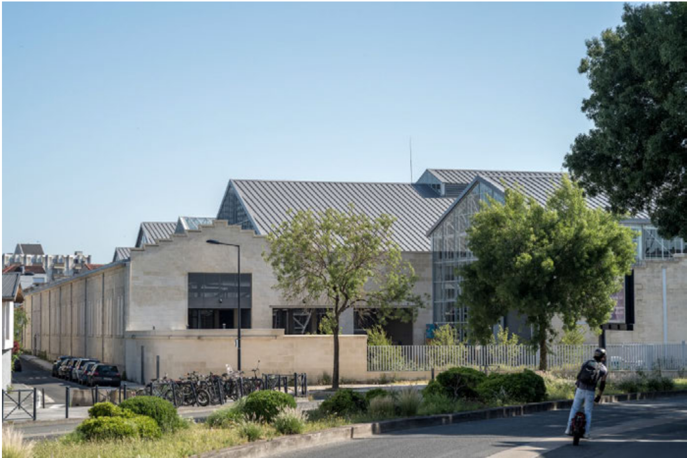
Vue sur l'entrée du site de remisage, angle boulevard Georges Pompidou et rue de Doumerc
