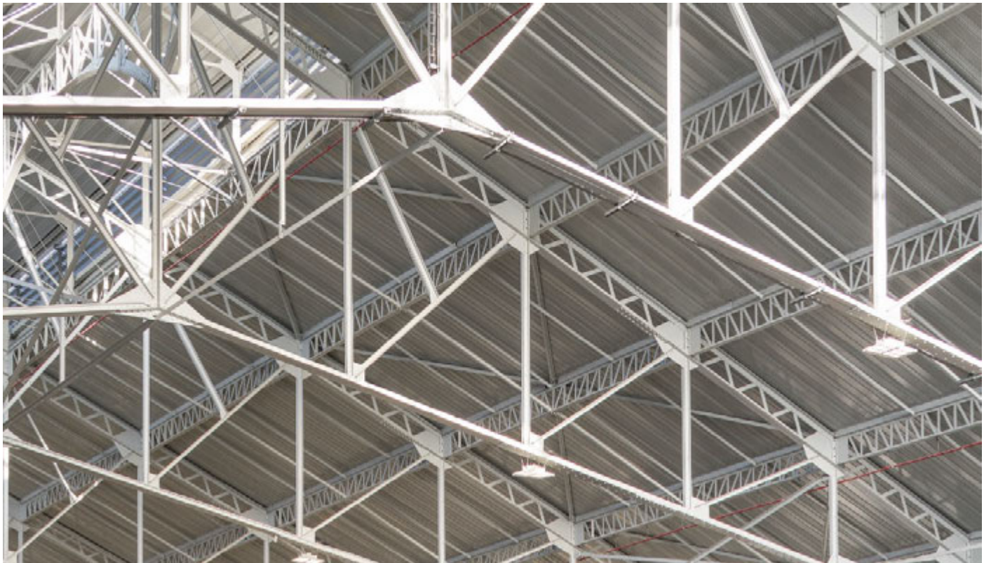
Détail sur la charpente métallique restaurée
