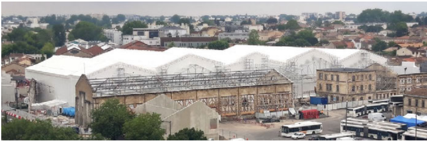
Réhabilitation de la halle pendant le chantier
