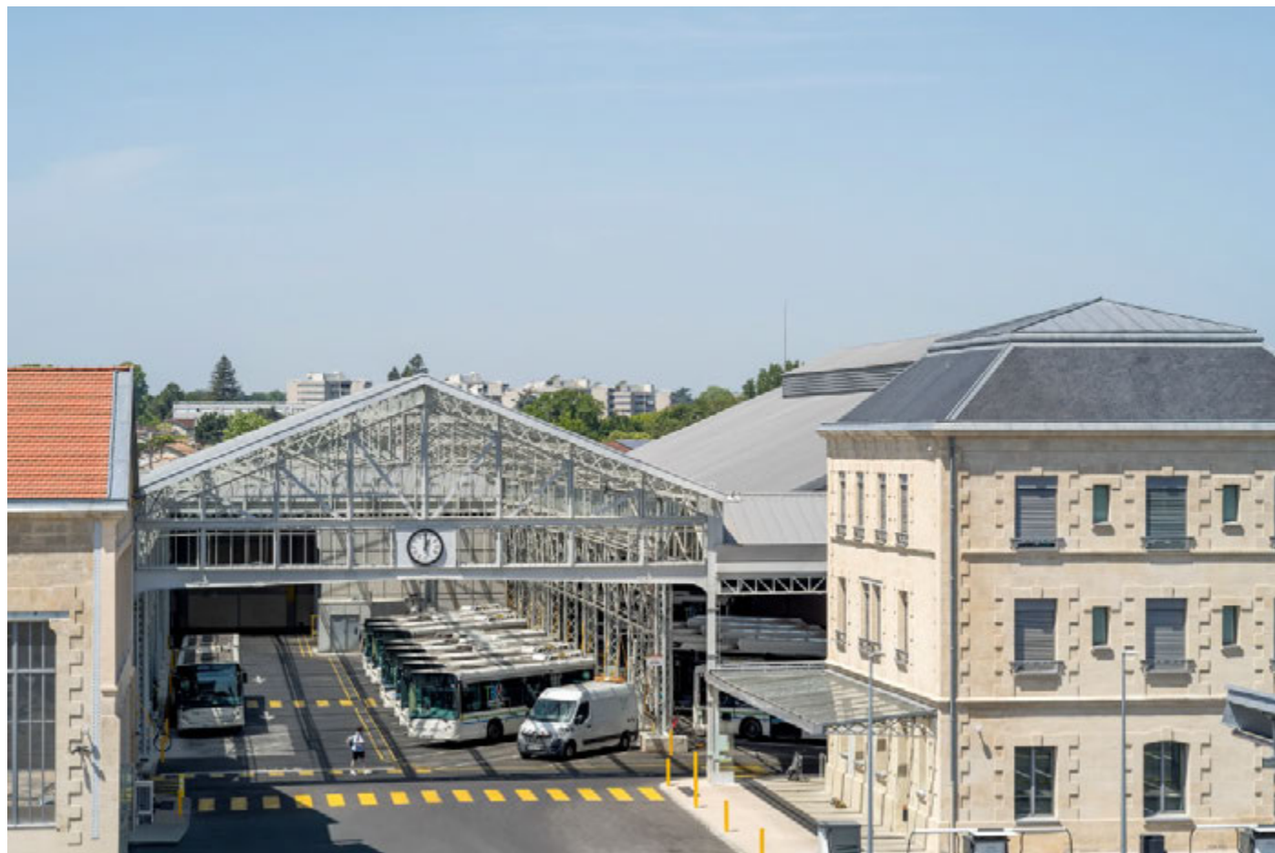
Nef centrale vitrée dans l'axe de la rue des pêcheurs / place de l'horloge
