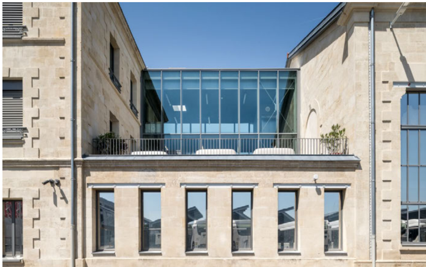
Terrasse accessible en R+1 entre le pôle médical et les espaces dédiés aux syndicats. Notre intervention restitue la volumétrie et l'aspect d'origine du bâtiment de 1899.
