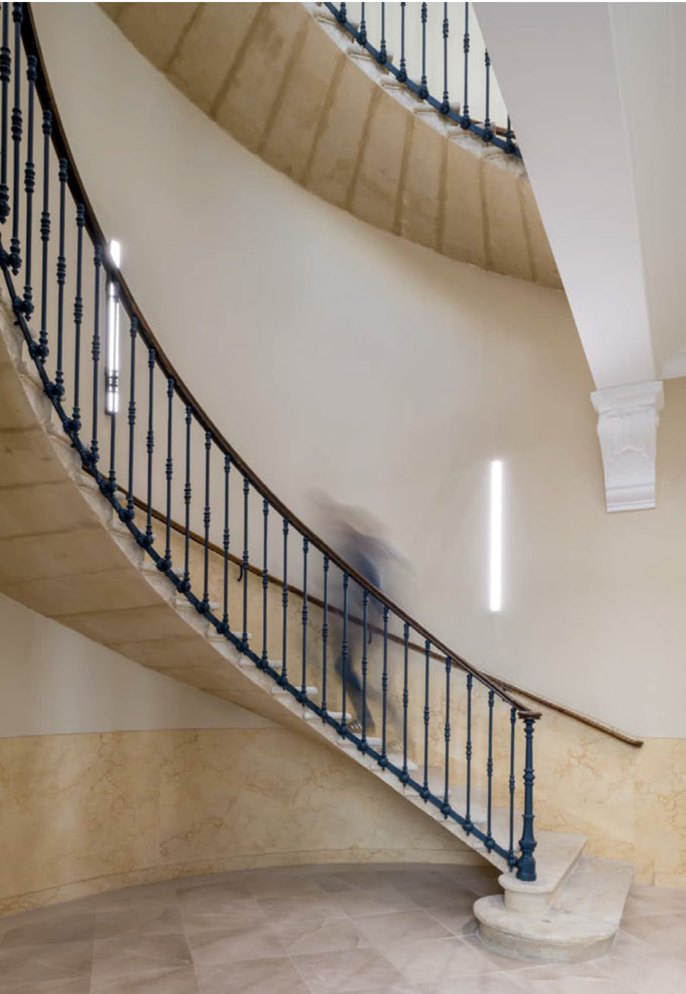
L'escalier sur voûte sarrasine, sols en pierre et décors en faux-marbre peint restitués
