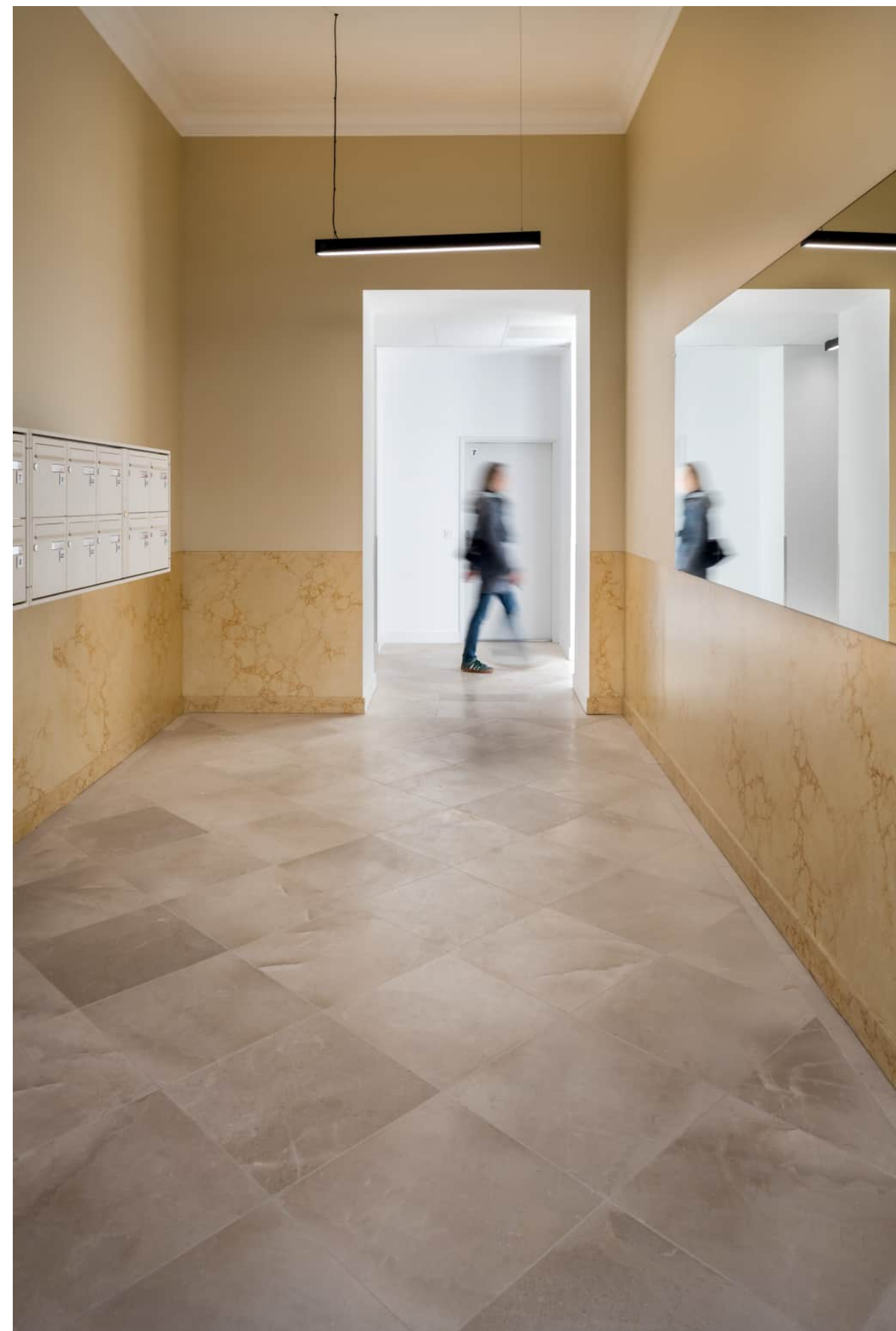
Hall d'entrée avec sol en pierre et décor en faux-marbre peint
