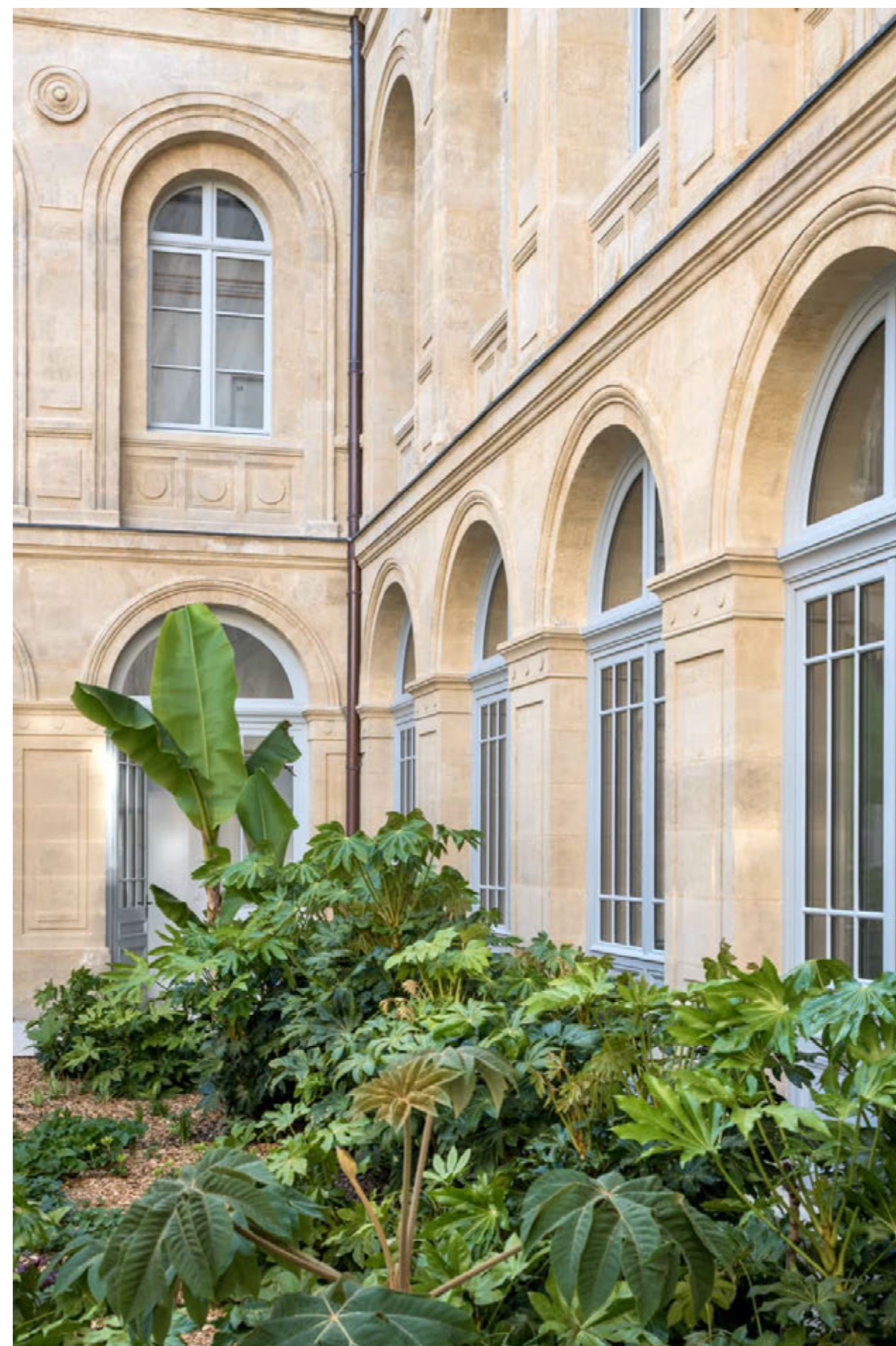
Menuiseries bois moulurées en continuité des modénatures de pierre
