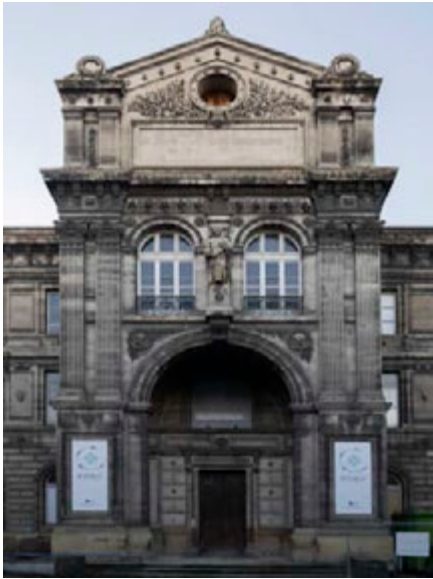
Le monument Castéja avant la réhabilitation
