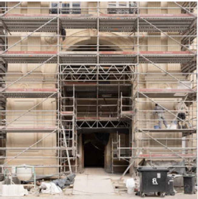
Restauration de la façade de l'avant-corps central
