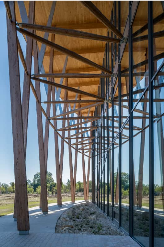
Une corolle extérieure composée de poteaux en bois moisé
