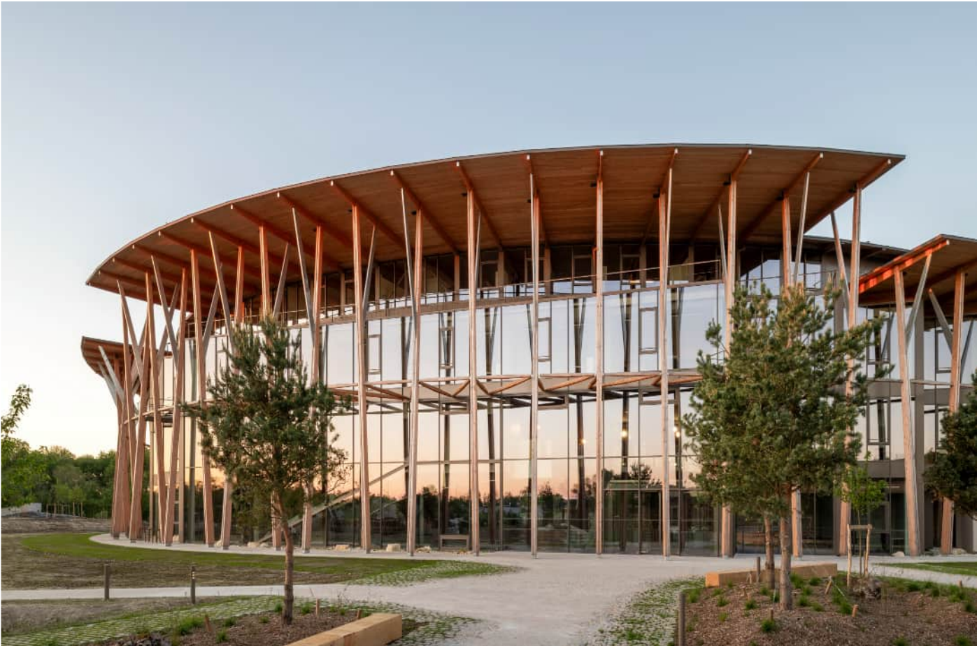
Une corolle extérieure composée de poteaux en bois moisé
